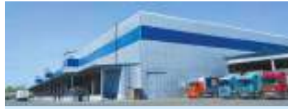
г. Москва, Производственно-складской комплекс
